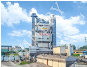
郑州国际机场320t/h沥青站工地 320t/h asphalt plant in Zhengzhou Airport, China
